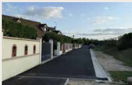
Avenue d'Herubé travaux terminés Réfection de voirie en enrobé avec bordure
