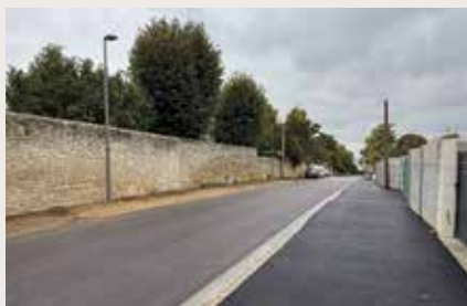
Rue du Pavé 2 e phase | travaux terminés Revêtement des trottoirs et pose de lampadaires à LED plus performants
