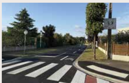
Avenue du Maréchal Foch travaux terminés Reprise des enrobées de chaussée et du traçage des itinéraires cyclables, création de dos d'âne de ralentissement à proximité des écoles maternelles et élémentaires
